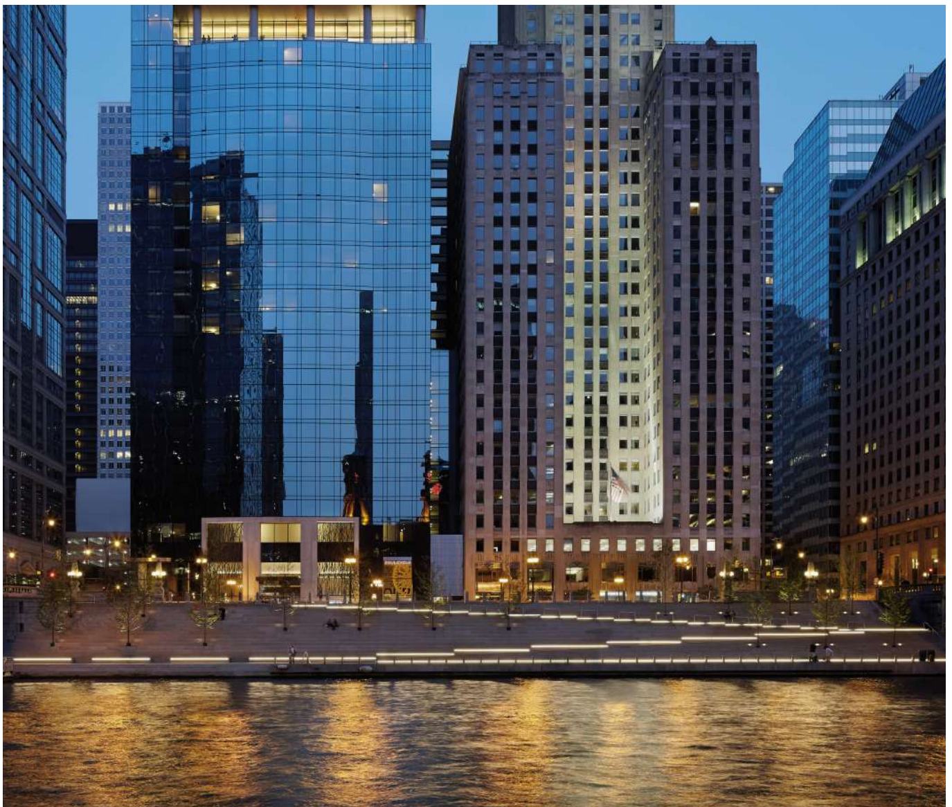
Chicago Riverwalk, USA
